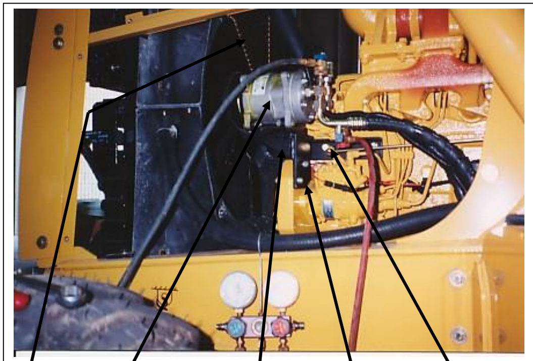
Fan screen cutoff
